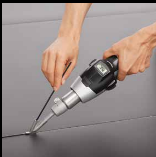
Сварка напольного линолеума
