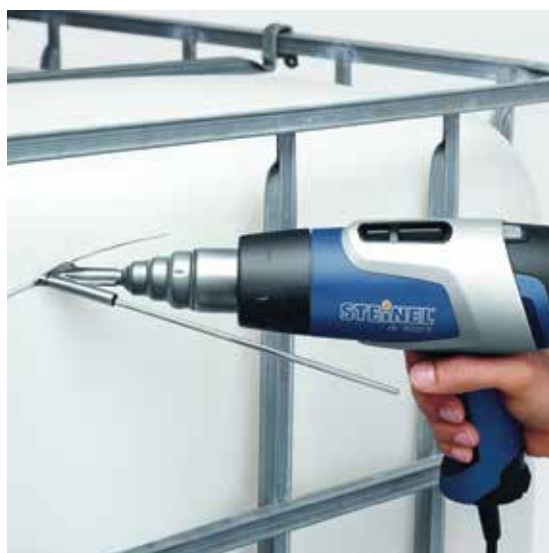
Ремонт. Заваривание ПВХ-бака для воды
