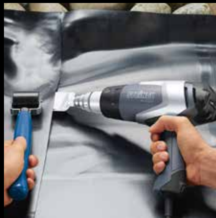
Сварка облицовки бассейна HG 2320 E
