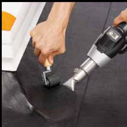
Сварка внахлест HG 2620 E
