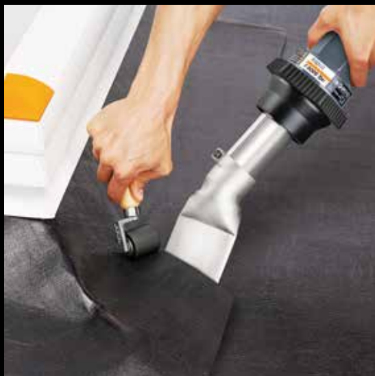
Сварка внахлестку легкого каркаса
